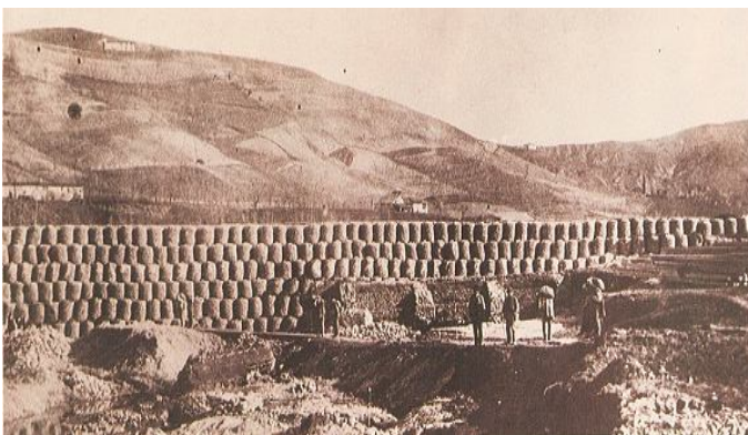
Рис. 1 Перший досвід застосування габіонів – берегоукріплення річки Рено в Болоньї, Італія 1894р.
