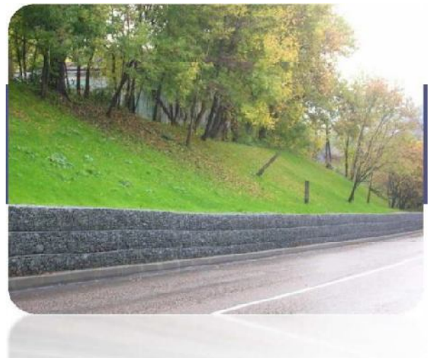
Рис.11 Підпірна стінка з коробчатих габіонів.
