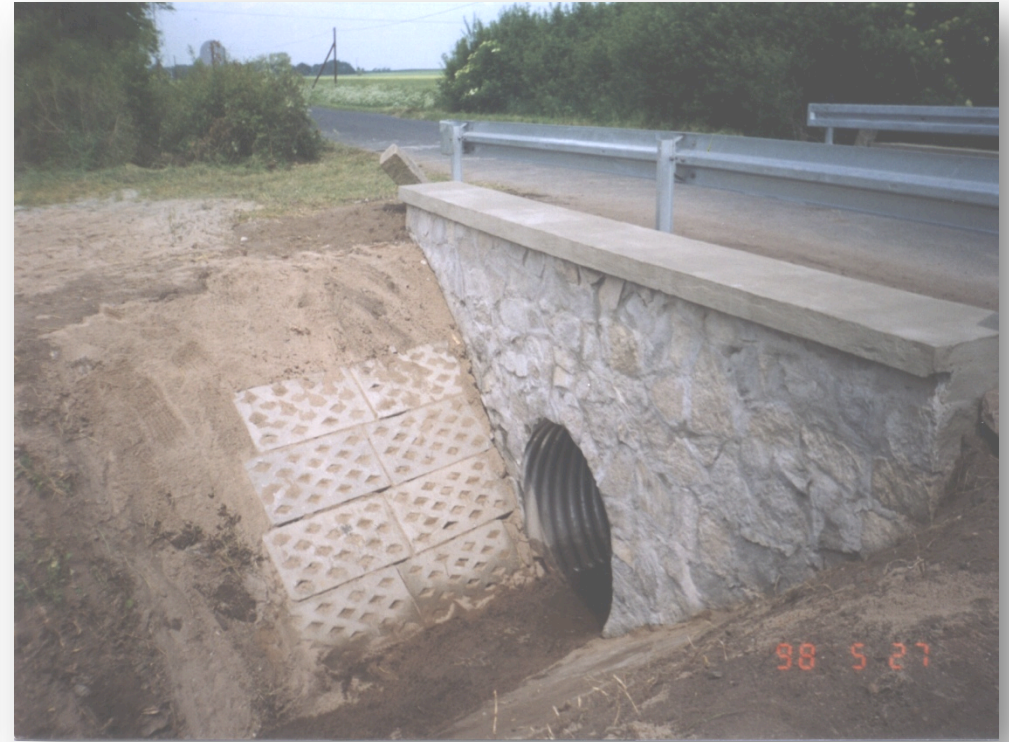
Объект после ремонта
