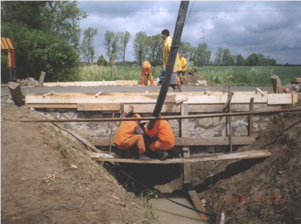
Инъектирование бетона
