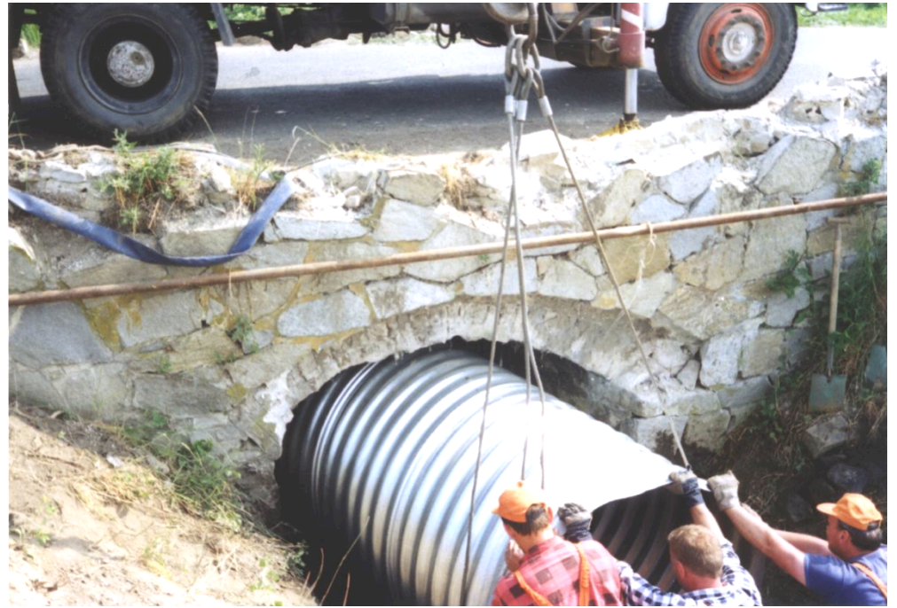
Затягивание трубы
