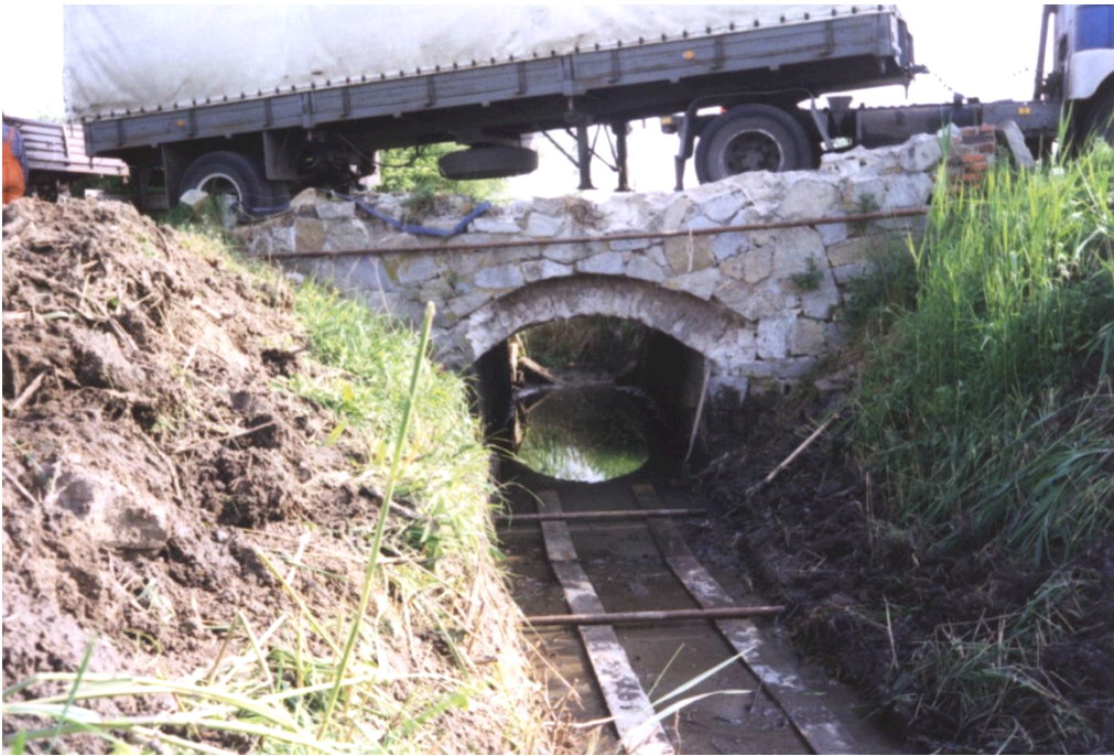
Объект до ремонта
